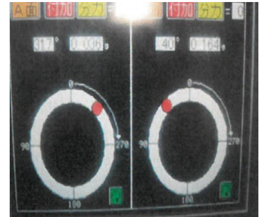
【 balanserによる振動の確認】
